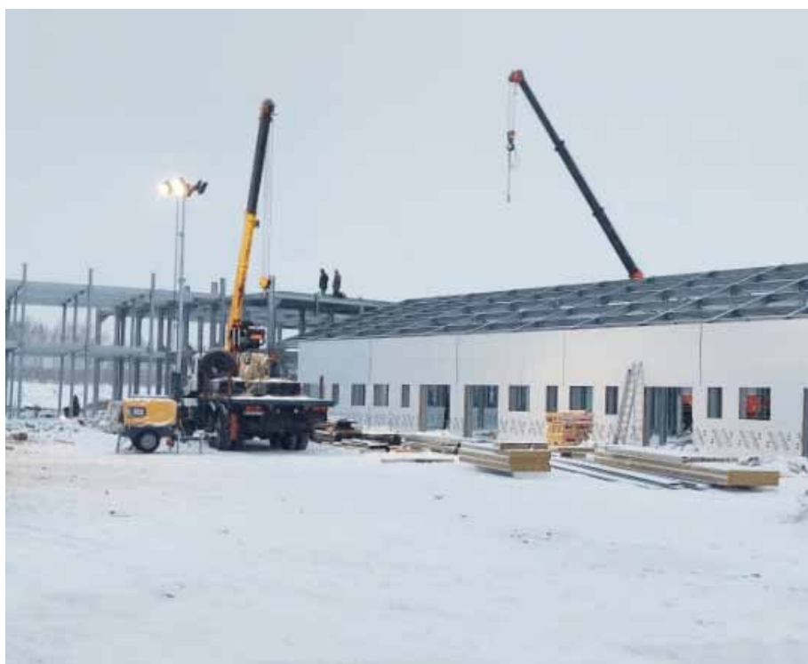
Строительство инфекционного госпиталя в г. Сибай
