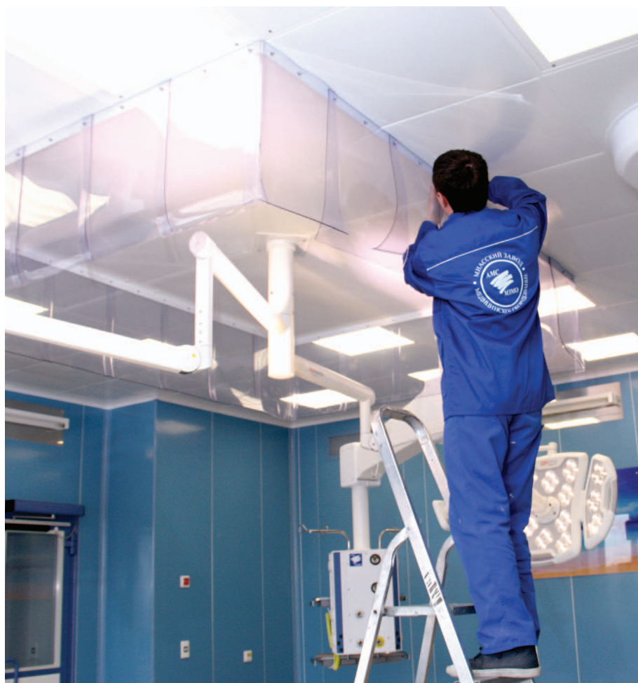
Монтаж ламинарного поля
