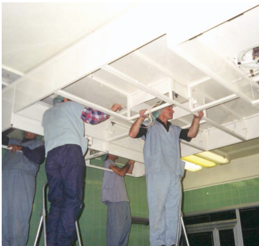
Монтаж первых комплексов чистых помещений
