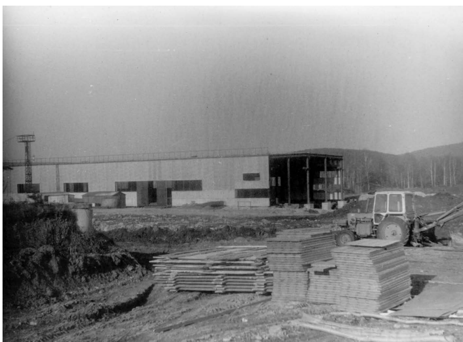
Строительство производственного корпуса
