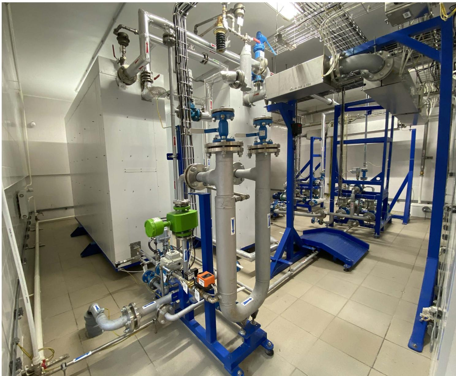
пературе, охлаждаются и сбрасываются в общую канализацию. Данный процесс происходит непрерывно и в автоматическом режиме. Выпускаемая линейка установок обработки сточных вод (УОС) включает устройства производительностью от 2 до 18 кубометров в сутки.
